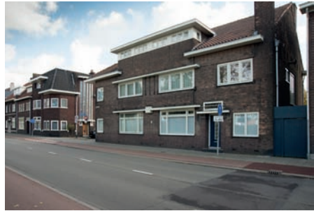
Stationsstraat 34 en Burgemeester Schoonheijtstraat 1, 2017.
