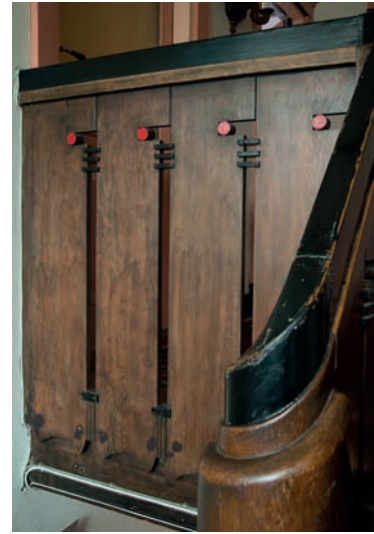
Detail trappenhuis, 2017. (Foto Bea Hoeks-de Laat)
