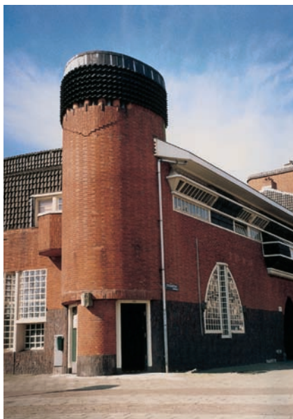
Gedeelte van het gebouw Het Schip door architect Michel de Klerk, 2017.
