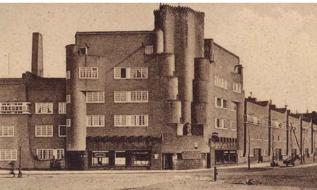
Woningen van De Dageraad ontworpen door de architecten Piet Kramer en Michel de Klerk, c. 1924. (Fotocollectie Museum Het Schip)
