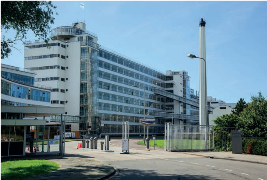
Van Nelle fabriek, Van Nelleweg te Rotterdam, 2014. (Foto N. de Jong, collectie Rijksdienst voor het Cultureel Erfgoed nr. 12211-36219)
