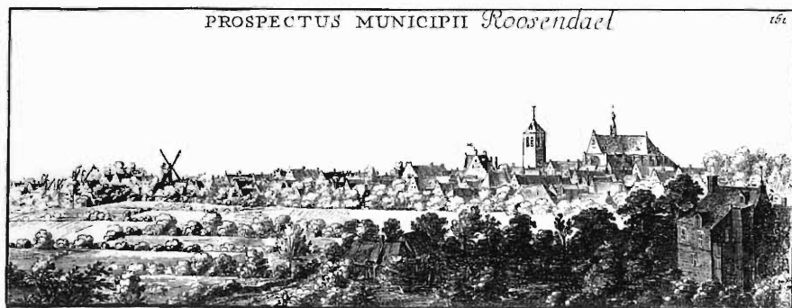
Gezicht op Roosendaal vanuit het zuid-oosten, 1655.
