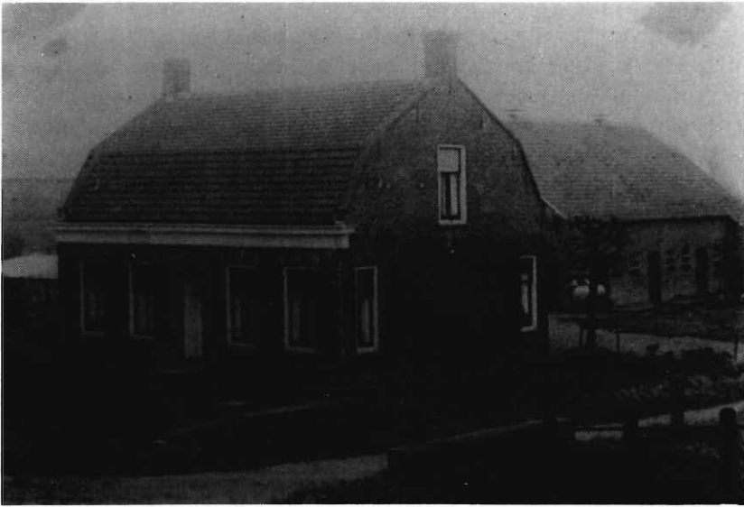
Boerderij Oostdijk 20 te Willemstad. In 1908 werd de oude boerderij van Adriaan Vos door de toenmalige eigenaar nagenoeg geheel afgebroken en opnieuw gebouwd; in 1944 is het pand door oorlogshandelingen verwoest. (Fotograaf onbekend; reproductie C. van Mastrigt)
